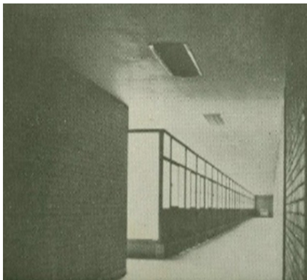
Pasillo de la planta baja.
